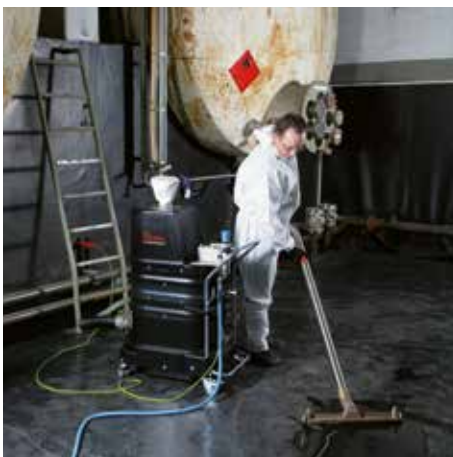
R01 P022 pour zone à gaz explosifs
